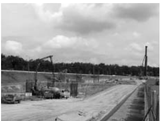
東部丘陵線の工事現場
