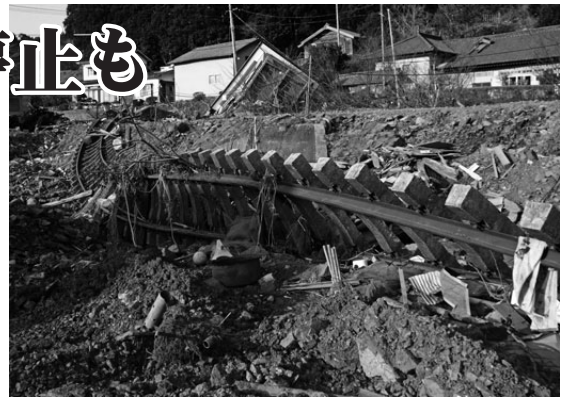
津波で曲がりくねった線路（岩手県大船渡市）
