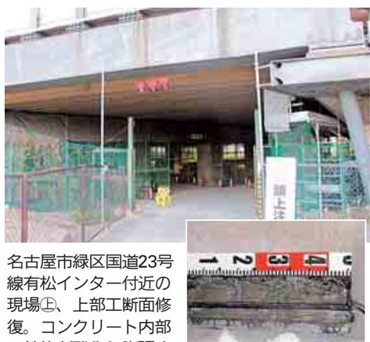
名古屋市緑区国道23号線有松インター付近の現場①、上部工断面修復。コンクリート内部の鉄筋が酸化し膨張する事でコンクリートが剥がれてしまっている②。耐久性が低下するため早めの処置が必要。
